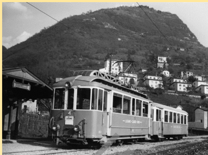
CFe 2/3 C4 con C41 "Viganello" con rimorchiata
